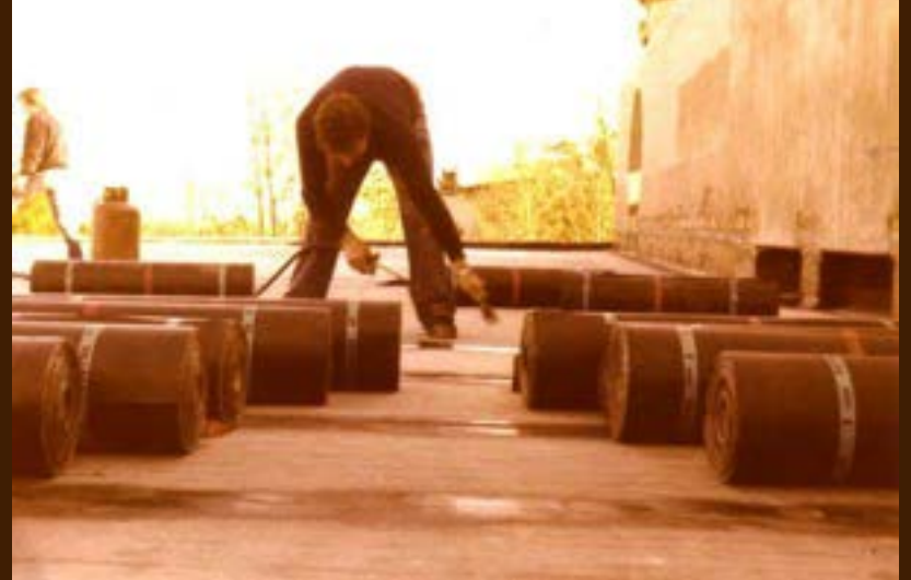
Il tetto viene impermealizzato.
